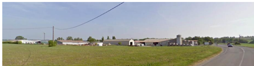
ZA les Pierrettes sud, Castelnau-Montratier : des bâtiments qui « émergent » du paysage sans s'y intégrer pour autant (couleur, matériaux, pas d'intégration par le végétal...).
