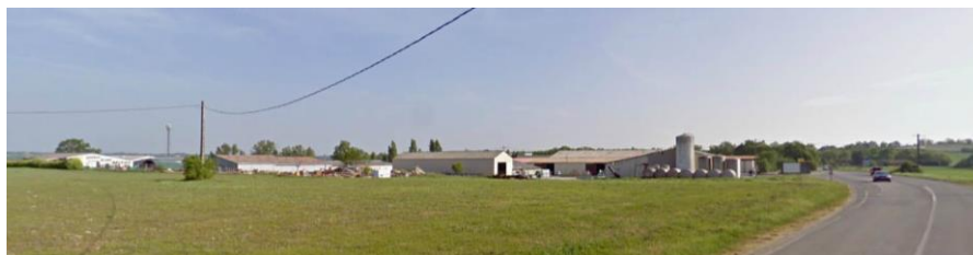
ZA les Pierrettes sud, Castelnau-Montratier : des bâtiments qui « émergent » du paysage sans s'y intégrer pour autant (couleur, matériaux, pas d'intégration par le végétal...).
