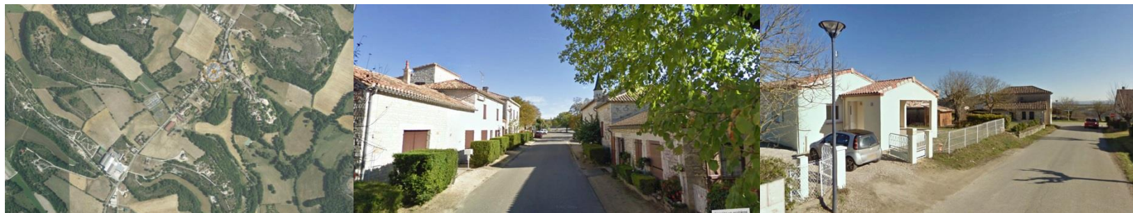
Belfort en Quercy : confrontation entre les nouvelles et les anciennes formes urbaines. Sources : Géoportail, EVEN
